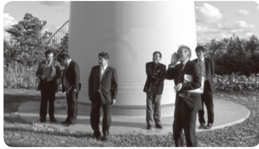
風力発電施設
