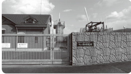
小水力発電施設
