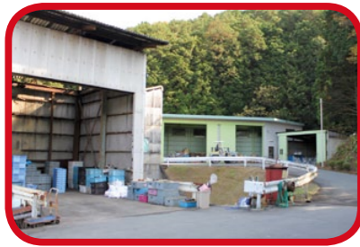
町美化センターへ持ち込まれたごみ
