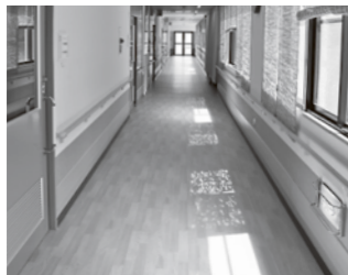
張り替えられた床
