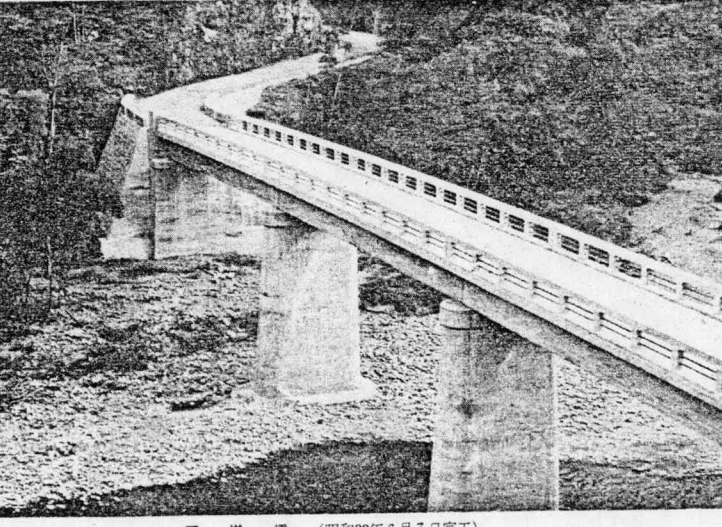
天 祥 橋。(昭和33年6月7日完工)
