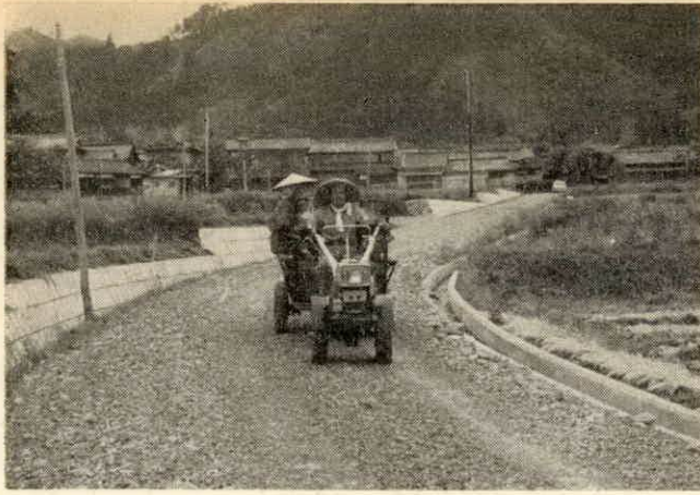
写真は完成した平生村道
