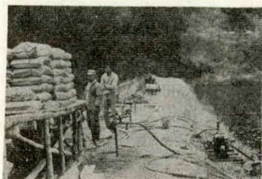
グラウト工事(牧戸)
