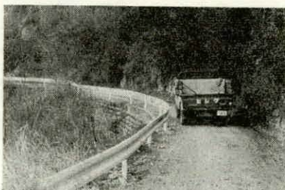
完成した田間のガードレール
