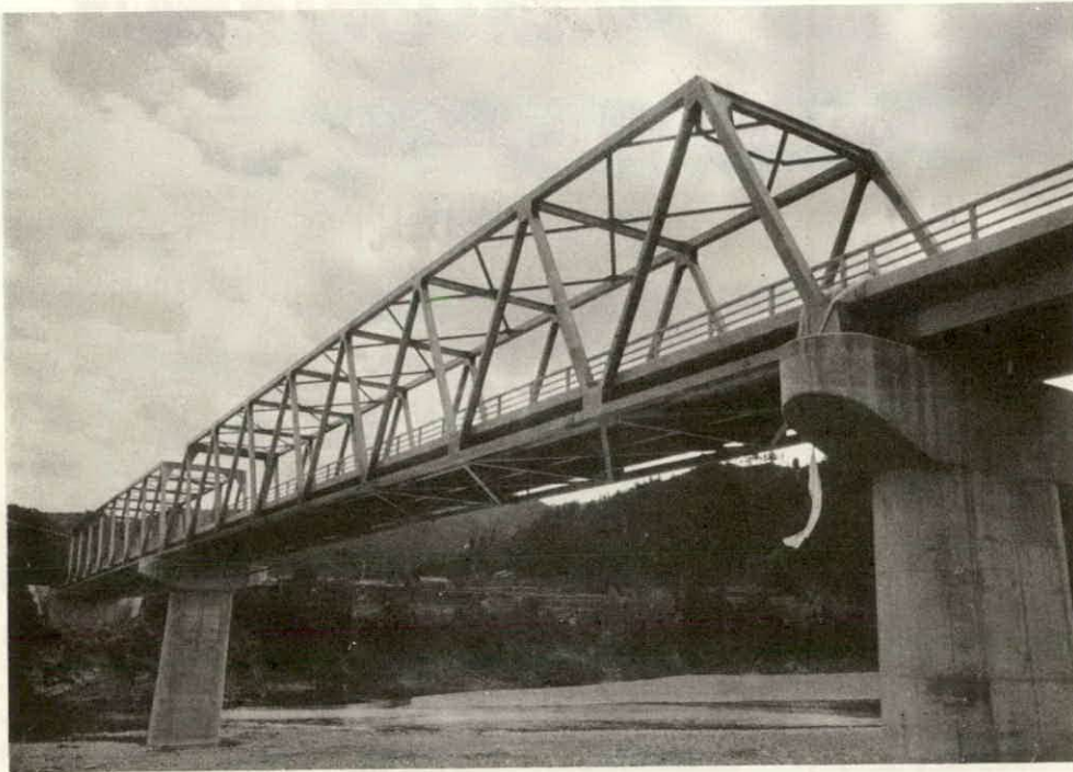
竣工が待たれる 鮎川大橋
