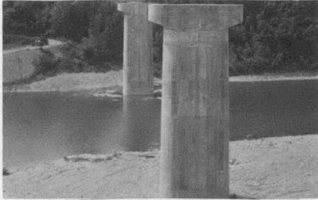
架設がまたれる田口大橋
