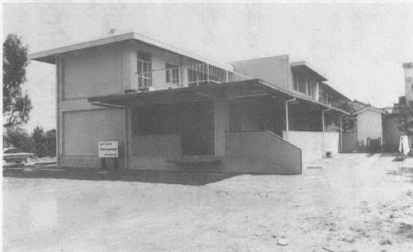
—年金積立金還元融資で完成の伝染病隔離病舎—
