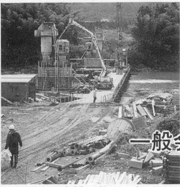
久具都比売橋下部工 急ピッチ
