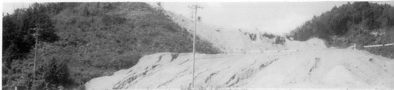
着々と進む公共用地造成
