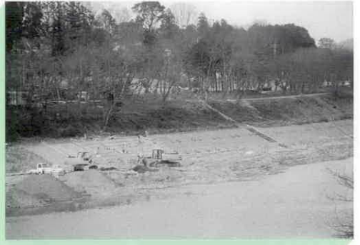
宮川護岸整備
