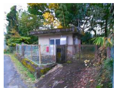
(旧) 棚橋浄水場
