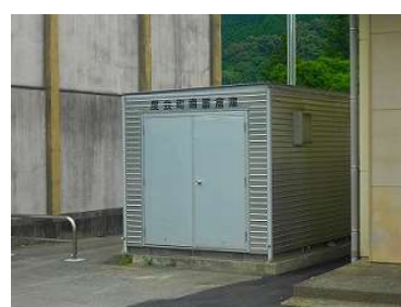
小川郷地区備蓄倉庫
