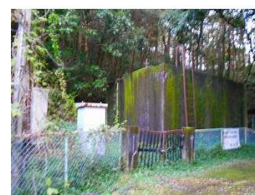
(旧) 棚橋配水池
