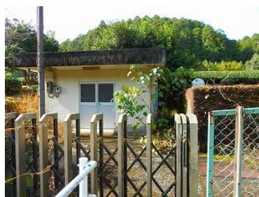
(旧) 立岡配水池
