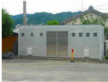
中川地区備蓄倉庫
