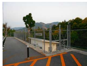
棚橋水源地（機械室）
