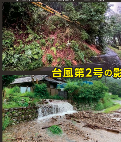
小萩地区 山水により土砂流出
