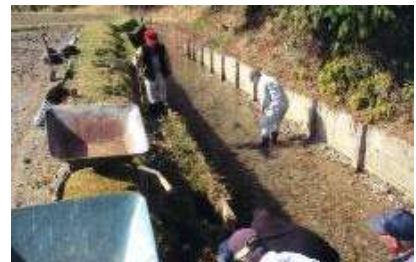
地域における水路の補修作業
