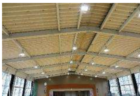
旧小学校屋内運動場吊り天井対策
