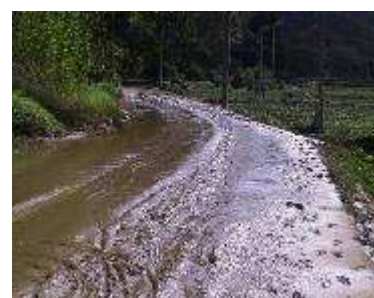
冠水でヘドロが堆積した町道川南線 (立花)
