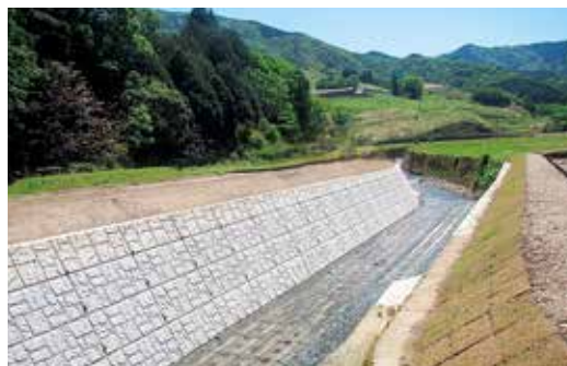
護岸の整備（準用河川五里山川災害復旧）
