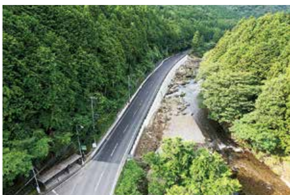
道路冠水対策（県道伊勢南島線）
