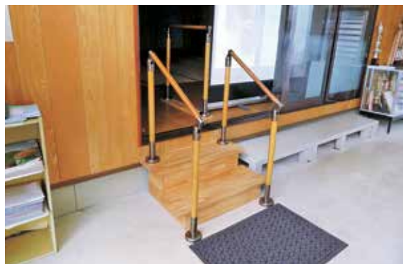
茶屋広区コミュニティセンター手すり設置
