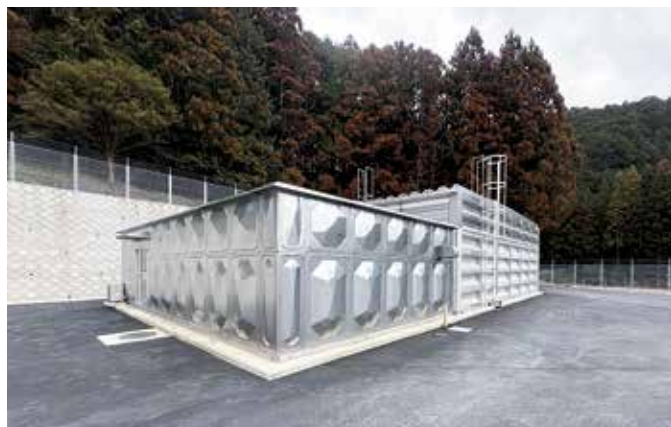
令和6年度築造 川上浄水場配水池
